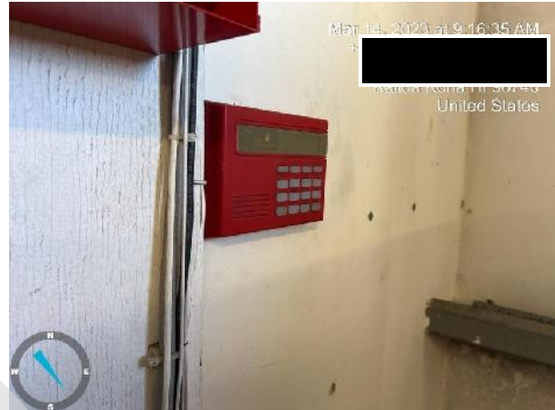
Fire alarm annunciator
